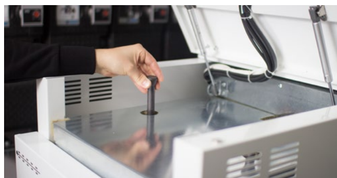
czyszczenie wymiennika kotła
